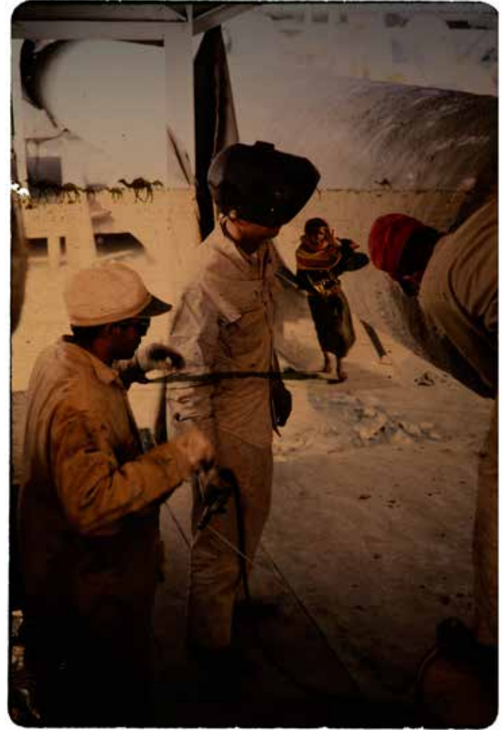
Pipeline from Ashab Al Lal: Fault Mirage, 2016 خط أنابيب من سلسلة أشهب اللال، ٢٠١٦
